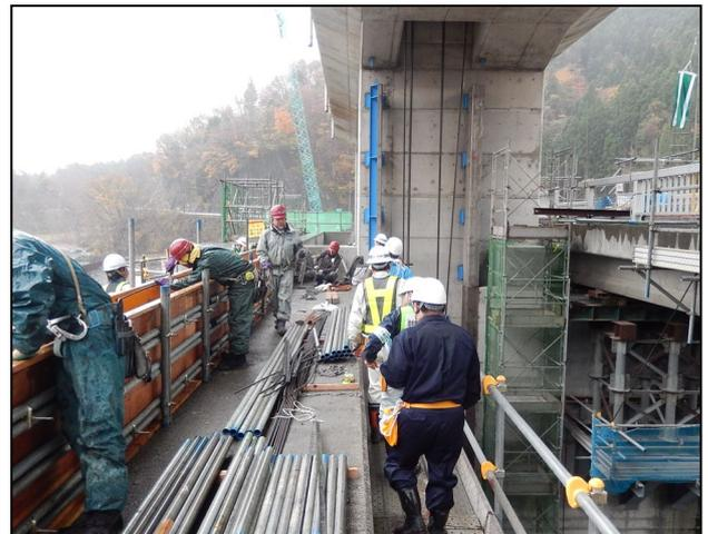
死亡労働災害は、墜落転落によるケースが上位を占めることから、今回のパトロールでは、足場の周囲に転落防止ネットが張られているか、安全ベルトを固定するロープが設置されているかなどの点を重点的に確認しました。
