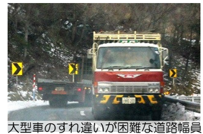
大型車のすれ違いが困難な道路幅員
