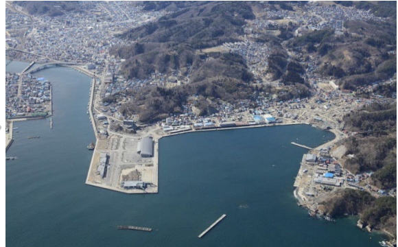
被災後(平成23年3月)
