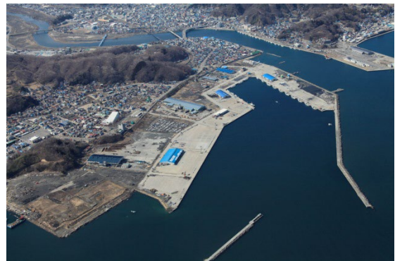
被災後 (平成 23 年 3 月)
