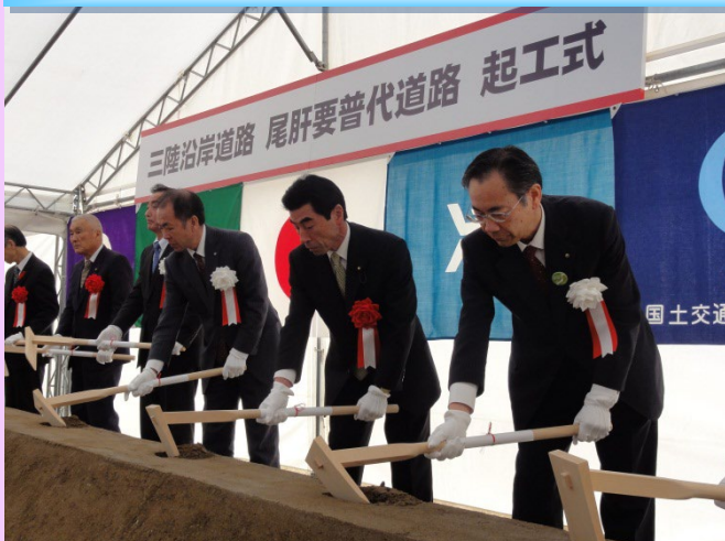
▲ 一日も早い完成と工事の安全を祈念して、来賓の方々や関係者による“鍬入れ”が行われました
