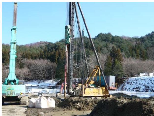
災害公営住宅建設工事（釜石市平田地区）
