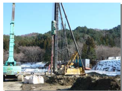
工事状況（釜石市平田）
