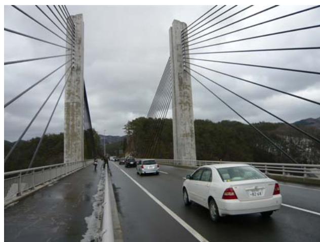
宮古盛岡横断道路「築川道路」開通！（盛岡市）
