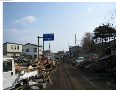
津波により寸断された野田山形線
