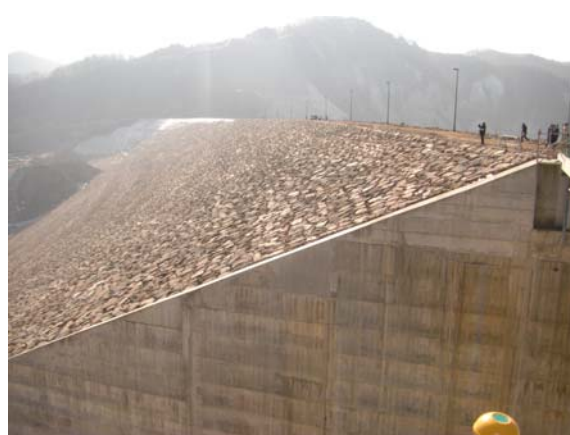
試験湛水を待つ胆沢ダム堤体
