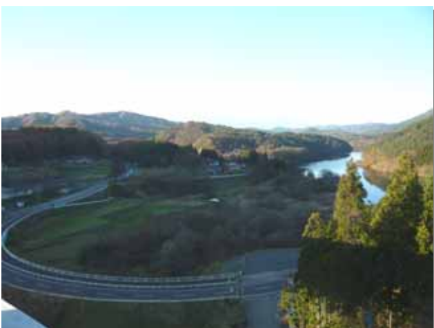
田瀬橋から国道 107 号と田瀬ダムを望む
