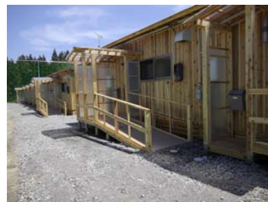
写真⑮ 応急仮設住宅 (田野畑村)
