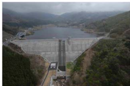
写真① 鷹生ダム
