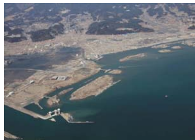
写真⑭ 陸前高田市の被災状況
