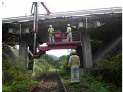
専用点検車による点検
