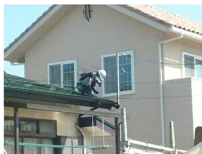
屋根の高圧洗浄の状況
