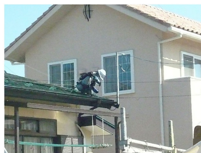
屋根の高圧洗浄の状況
