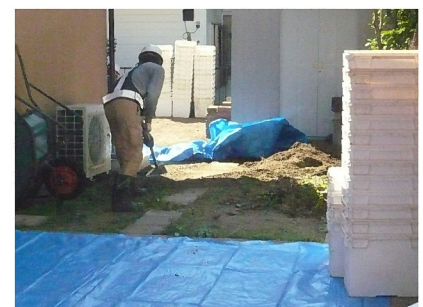
庭の表土の剥ぎ取り状況 表土は右の白い容器に入れて埋めます
