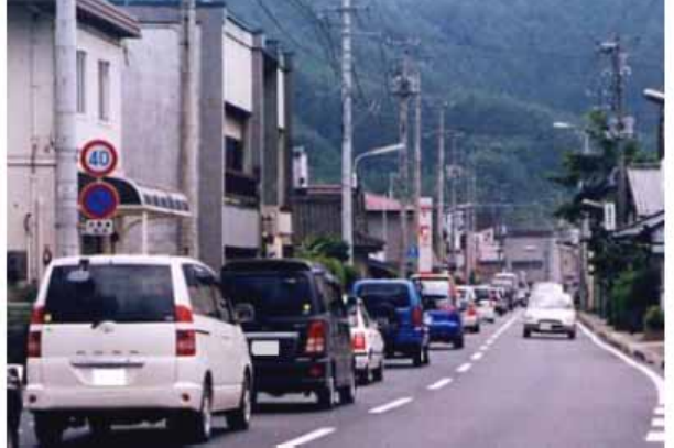
整備前の国道 45 号の渋滞状況 (鶴住居交差点付近)
