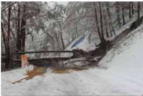
主要地方道一戸葛巻線 葛巻町小田地内
