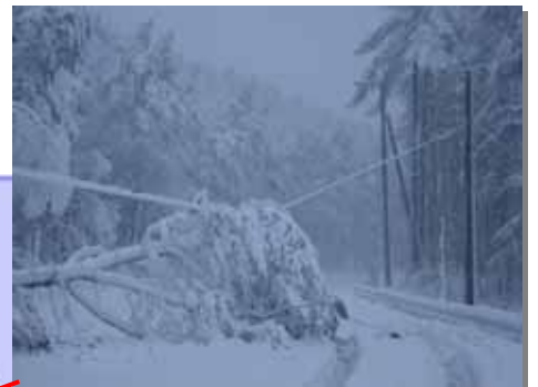
一般国道 281 号 岩手町大坊峠地内
