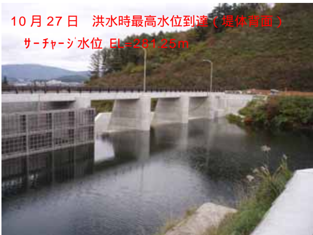
10月27日 洪水時最高水位到達(貯水池) サーチャージ水位 EL=281.25m
