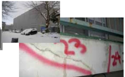
計画修繕例:外壁(亀裂補修)の状況
