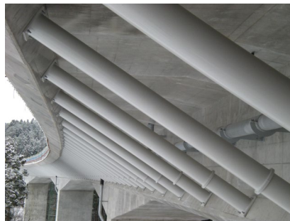
鋼管ストラット部
