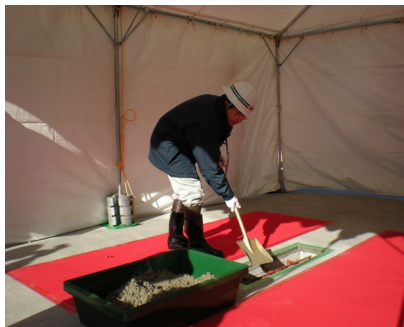
高橋築川ダム事務所長 コンクリート投入
