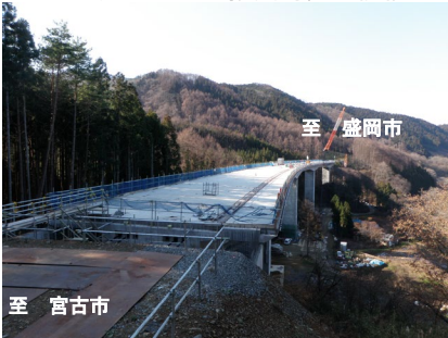
付替国道 3 号橋全景
