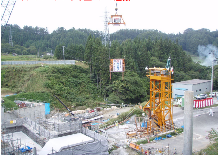
150トンクレーンによる生コンの運搬
