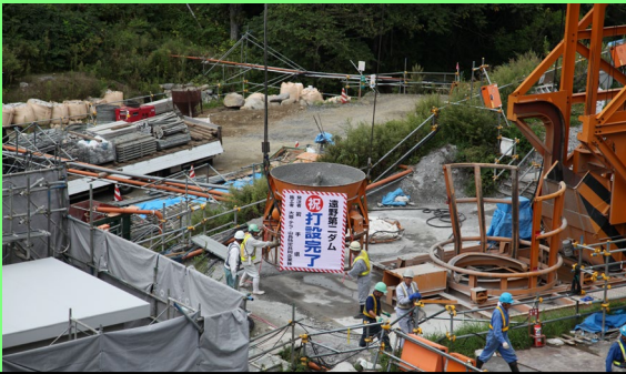
生コンをバケツに入れてクレーンで吊り上げます
