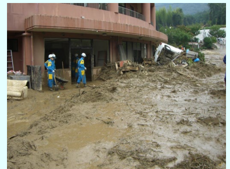
中国・九州北部豪雨による被災状況 (展示写真より：山口県写真提供)
