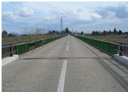
舗装のひびわれ、高欄の損傷
