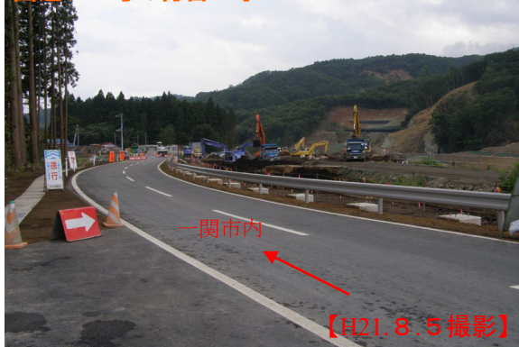
国道342号の付替工事
