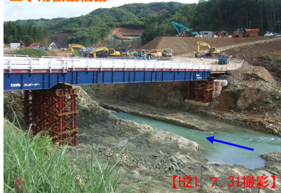
工事中仮設橋梁
