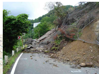
地震直後の被災状況（H20.6）
