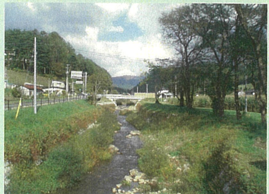
写真：一級河川元町川河川等災害関連事業現場
