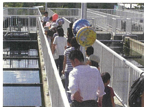
下水道ツアー(最終沈殿池)
