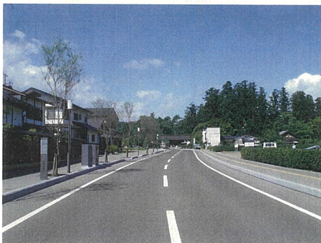
街路完成写真
