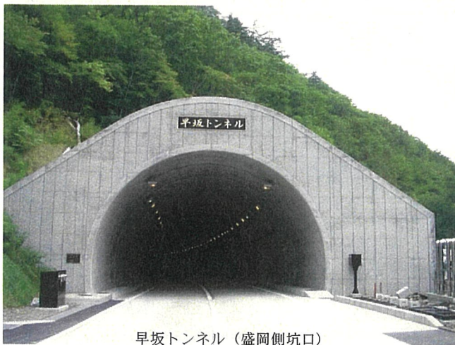
早坂トンネル（盛岡側坑口）
