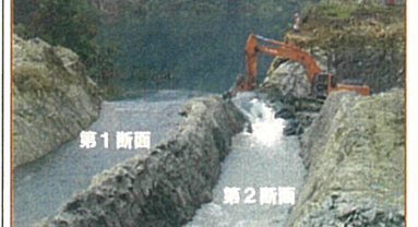
直轄砂防災害関連緊急事業「せき止め湖対策」(6/21:第1断面通水、7/5:第2断面通水)
