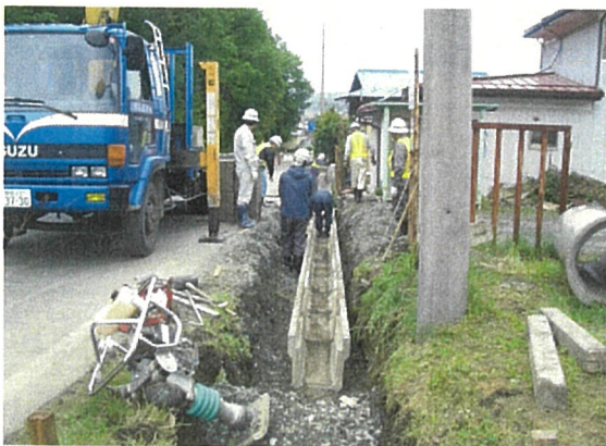
住民と町職員が協力して作業が進められました
