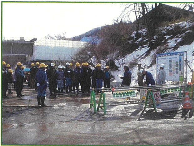
現場に設置された大きな工事説明看板の前で事業概要や架設方法等の説明をしました。
