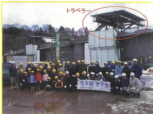
建設中の豊年橋をバックにみんなで記念撮影をしました。帰りまでにプリントして全員に配布しました。
