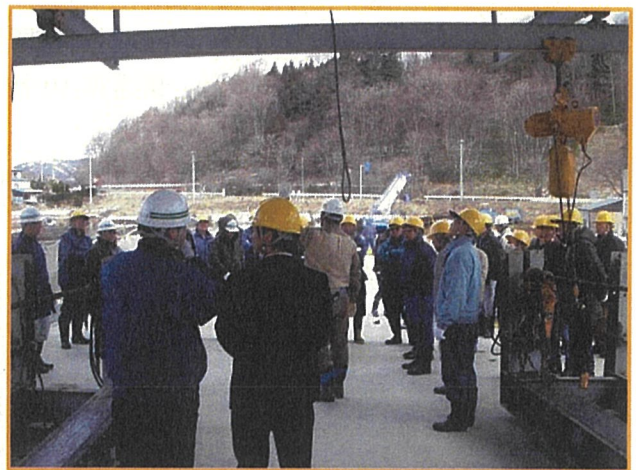
桁の上にあがり、トラベラーについての説明を聞いているところです。
