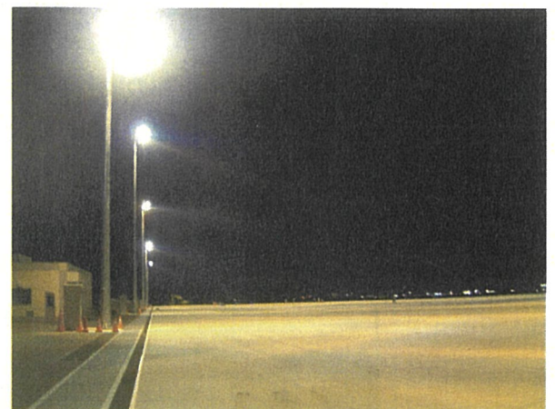
点灯状況(照度測定)
