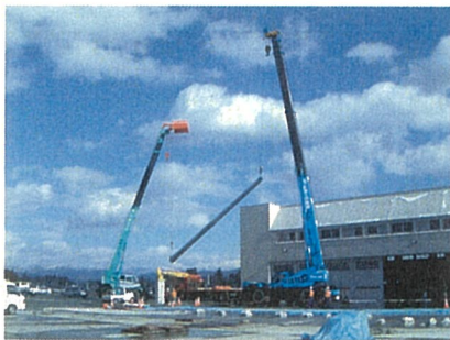
クレーン2台で柱の建て込み
