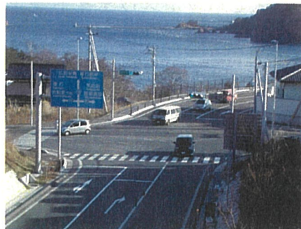
工事起点からの眺め
