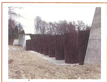
鋼製スリット部
