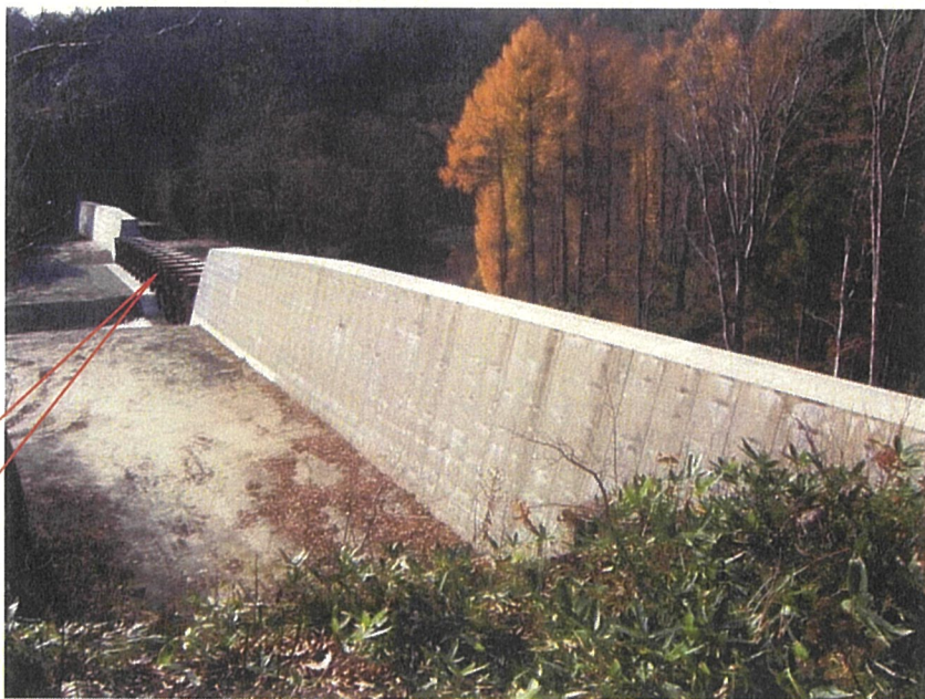
川船2号堰堤 全景
