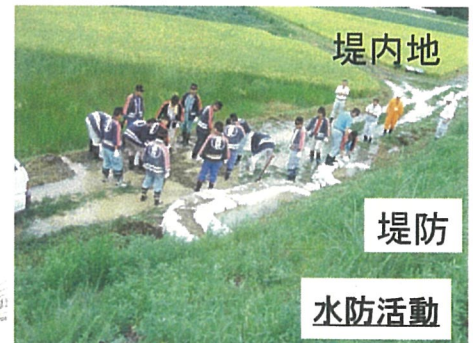
堤防法尻付近の漏水状況
