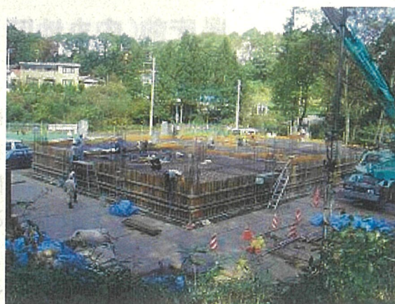
柴沢ポンプ場の施工状況
