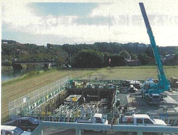
舟田ポンプ場の施工状況
