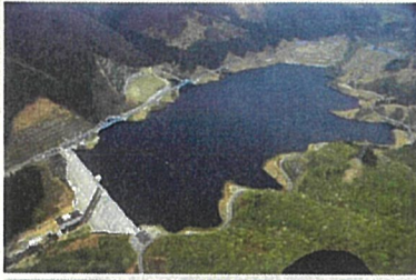
鷹生ダム(平成18年度完成)
