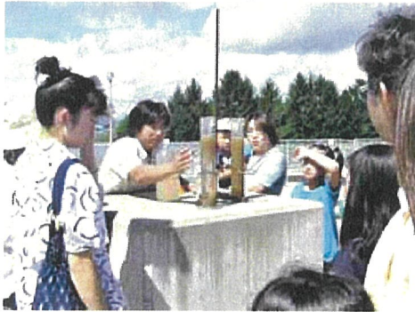
下水道ツアー（最終沈殿池）
