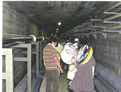
下水道ツアー（管廊）
