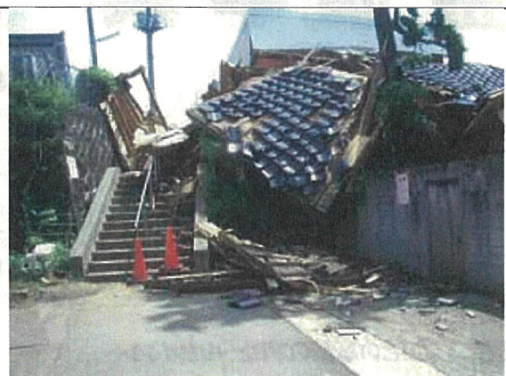
完全に倒壊し、通路を塞いでしまっている。
