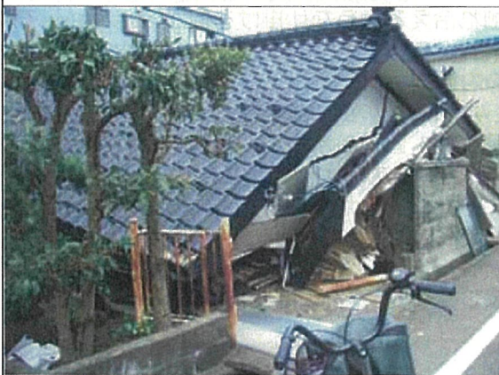
1階部分が完全に押し潰されている。
