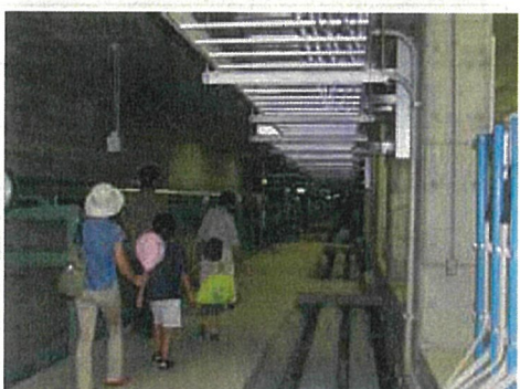
下水道ツアー（管廊）
