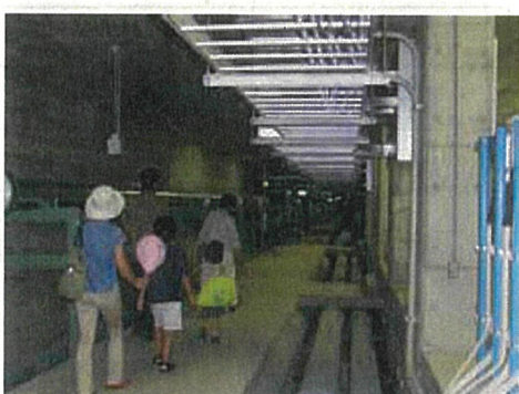
下水道ツアー（管廊）
