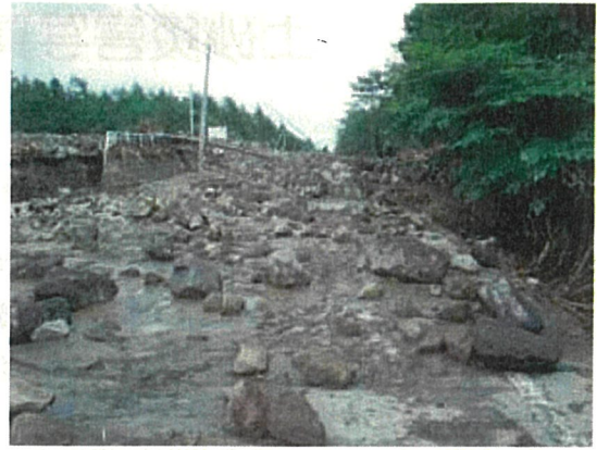
平成18年8月に雫石町御神坂地区で発生した土石流災害
