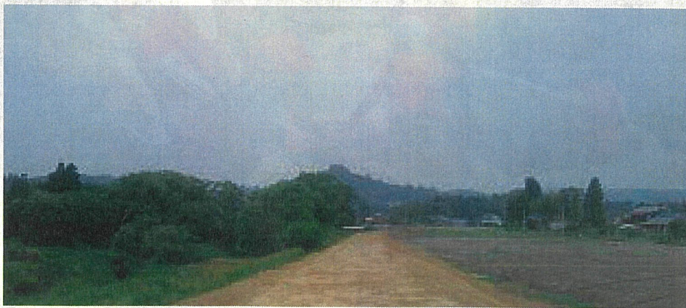
緊急的な盛土
