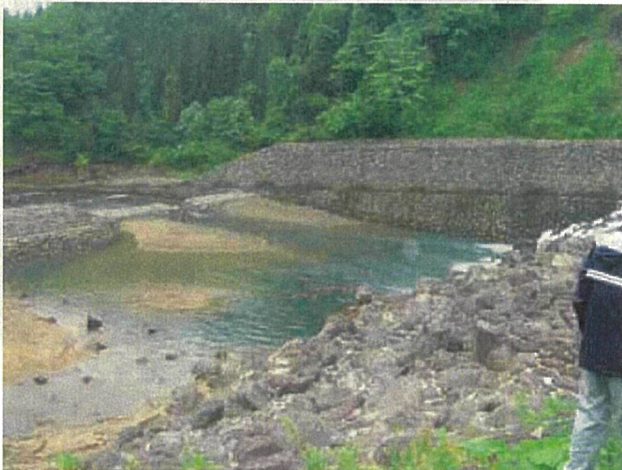
写真4 玄武砂防えん堤 魚道も見えます。
