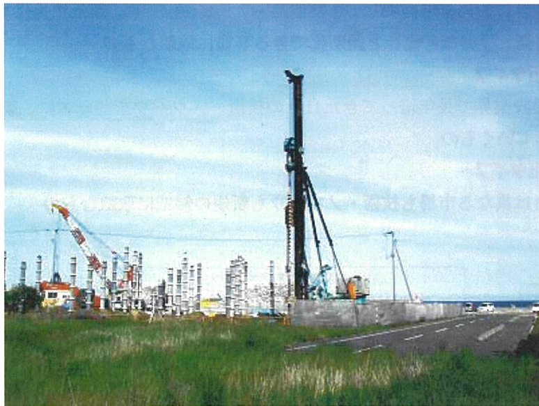
新工場建設工事風景
