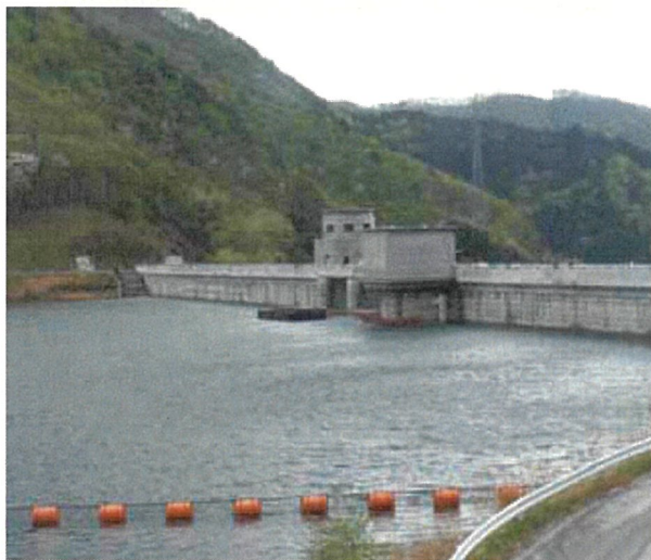
最高水位（サーチャージ水位）のダム湖
