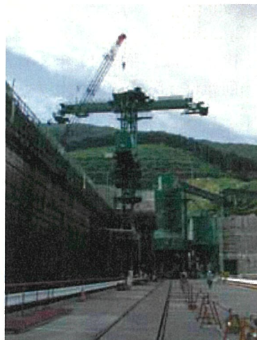
槌型クレーン（ライジングタワー）
