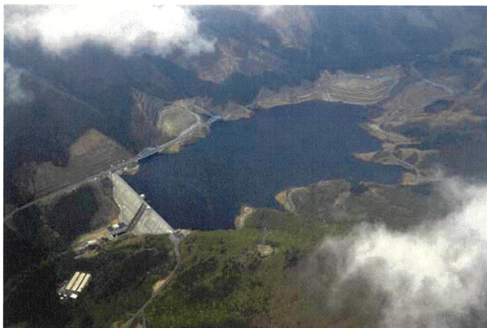
鷹生ダム全景
