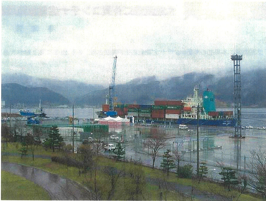
コンテナ船とターミナル全景
