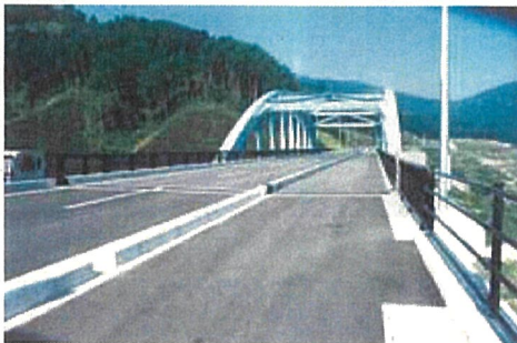
完成した付替県道
