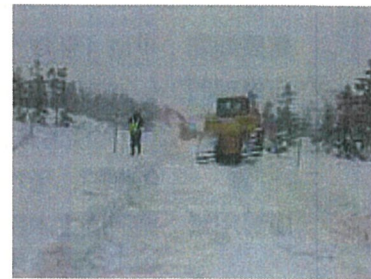
開通前の除雪作業
